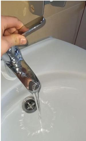
**Bild 1:** Manuelle Betätigung der Endzapfstellen, Bild: Dr. Georg Scholzen
